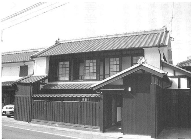
空き家の保存修理事業（修理後）
