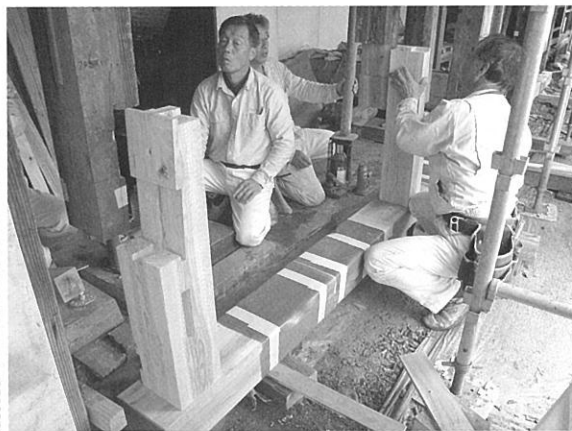
修理現場 伝統建築技術の地覆と柱金輪継ぎ
