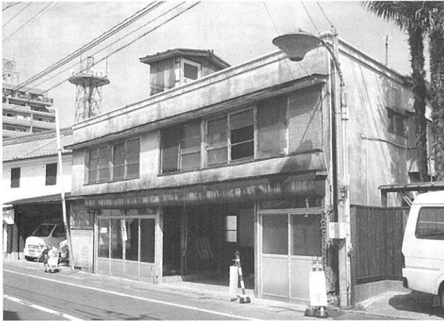
空き家の保存修理事業（修理前）
